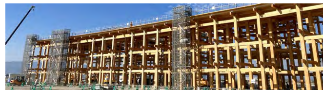
大屋根リング施工風景
