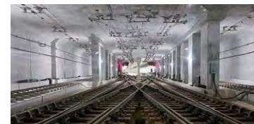
大阪駅トンネル 福島筑前橋トンネル
