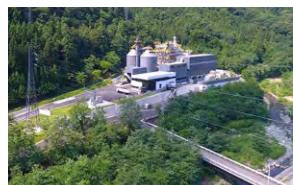
大月バイオマス発電所 (国内木質燃料専焼)
