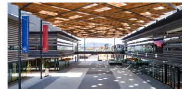
奈良県コンベンションセンター
