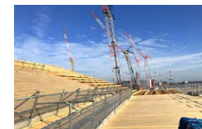
CLT床材施工風景
