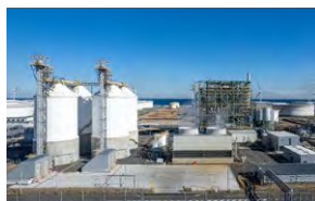
大林神栖バイオマス発電所
