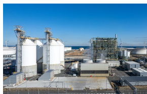
大林神栖バイオマス発電所
