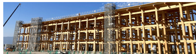
大屋根リング施工風景
