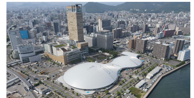
新香川県立体育館（上：BIMデータ、下：施工中の写真）
