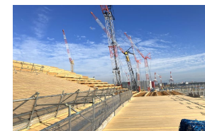
CLT床材施工風景
