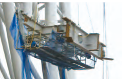
↑鉄骨の安全ネットも先に地上で取り付けから吊り上げられる
