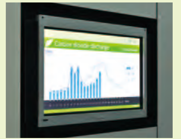
↑ モニタリングデータを活用して省エネルギーデータを見やすく提示
