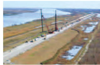
堤防改修工事の現地の状況
