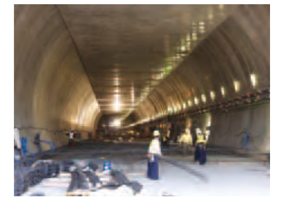
↑シールドマシン通過後整備された地上発進口
