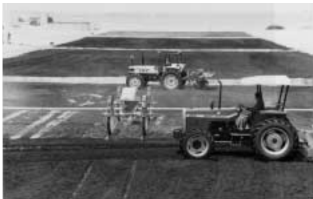
バイオレメディエーションによる油汚染土の浄化
