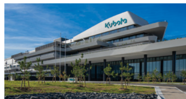
株式会社クボタ グローバル技術研究所 設計・研究棟外観
