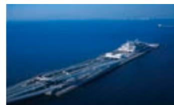
1997年 東京湾アクアライン 最大水深28m、最大土被り16m、距離約 2.8kmの海底トンネル
