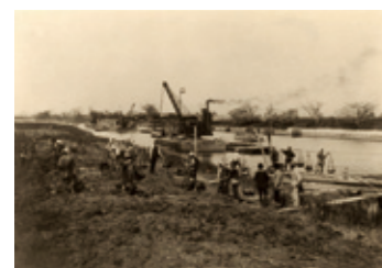
1905年 大阪築港 浚渫、埋立地造成のほか、大栈橋などの 港湾施設を建設。当時の大阪市の年間予 算20年分に相当した大規模工事
