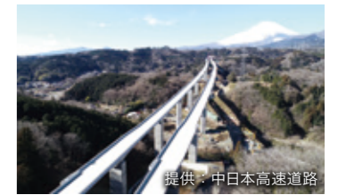
提供: 中日本高速道路 新東名高速道路 中島高架橋工事(静岡県)
