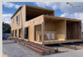
② ユニット揚重・設置
