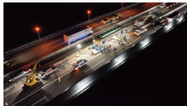
「DAYFREE®」による床版取替工事(東名多摩川橋)
