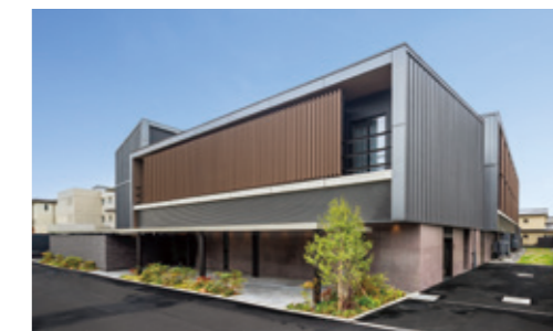
2023年3月 仙台梅田寮 木造ハイブリッド構造の社員寮。国産の木材約900m 3 を使用することで、建 物のライフサイクルを通じ約540tのCO 2 を固定し、カーボンニュートラルの 実現と社員の健康・快適性というウェルビーイングの向上に貢献
