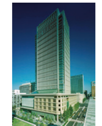
2002年 丸の内ビルディング 日本を代表するオフィスビル「丸ビル」の建 替え工事。廃棄物ゼロエミッション・モ デル現場として建設廃棄物の削減に挑戦
