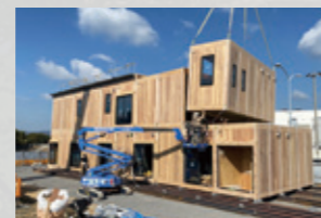
③ ユニット揚重・設置(2階部分)
