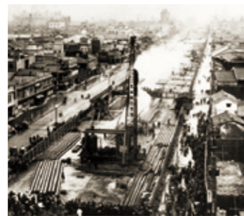
1933年 地下鉄御堂筋線 （淀屋橋-北久太郎町間） 大阪初の地下鉄となった現在の御堂筋線 工事。一帯に横たわる軟弱地盤を掘り、 河川の下をくぐるなど現代でも語り継が れるほどの難工事を実施
