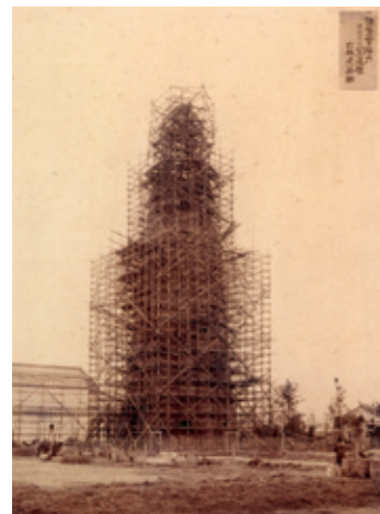
1903年 第五回内国勲業博覧会 望遠楼「大林高塔」 地上45mのエレベーター付き木造高層建築
