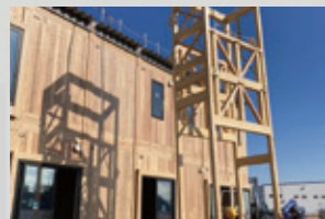
⑤ 外部通路ユニット揚重・設置
