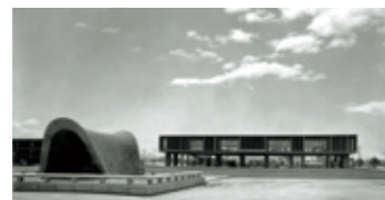
1955年 広島平和記念資料館 復興のシンボル。戦後の建築物として初 めて国の重要文化財に指定
