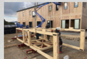
④ 外部通路ユニット地組
