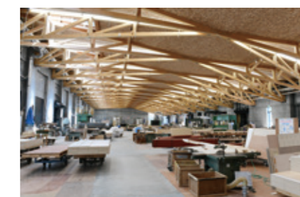
2023年6月 内外テクノス 本社工場 延べ面積8,000m 2 超の木と 鉄筋コンクリートのハイブリ ッド構造による、当社グループ内 外テクノスの大規模工場
