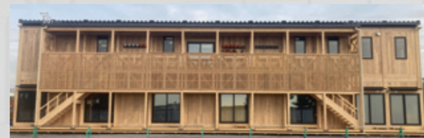
完成した木造仮設工事事務所
