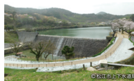
2020年 千本ダム堤体補強工事 1918年完成の国の登録有形文化財指定のダム。 ダム機能維持と文化遺産保持のため、国内初の堤 体PSアンカー工法を耐震補強に採用
