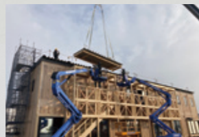
⑥ 屋根ユニット揚重・設置
