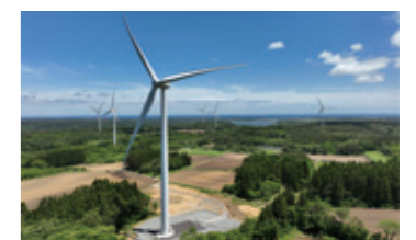
上北小川原風力発電所
