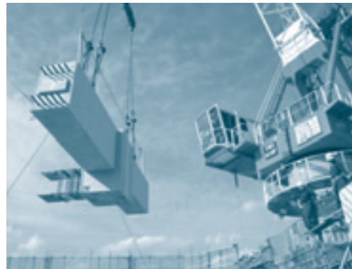
プレキャスト化された部材を現場で設置
