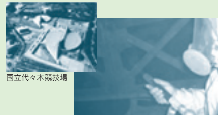
国立代々木競技場 「ドライアイスプラスト工法」実施状況 ※ドライアイスは工業副産物の排気ガスから作られています。新たに二酸化炭素を排出するわけではありません。
