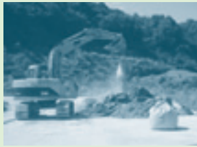
汚泥改良状況
