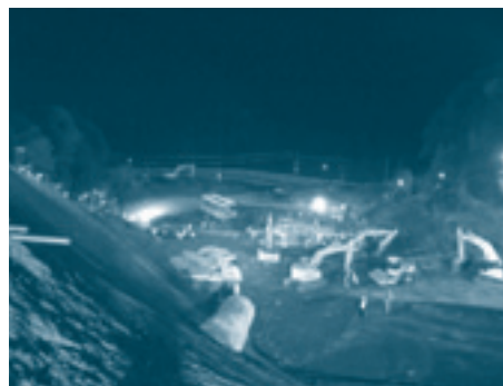
昼夜兼行で進めた復旧工事
