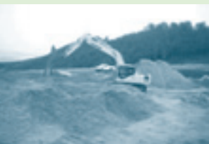
「タイヒシャトル工法」二次混合状況
