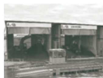
油混じり汚泥処理状況
