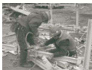
手作業による鋼材解体
