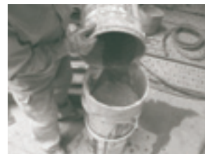
残モルタル濾過作業
