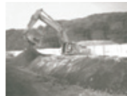
【写真2】油汚染土浄化工法「バイオヒートパイル工法」
