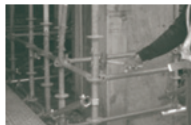
ハンマーによるくさび打込作業
