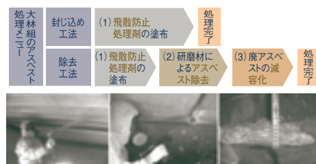
(1) アスベスト飛散防止処理材「ニューダイロック」の塗布 (2) 研磨剤(ドライアイス)噴射によるアスベスト除去 (3) 圧縮袋による廃アスベストの減容化 大林組のアスベスト処理メニュー
