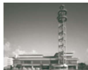
所在地: 沖縄県那覇市 延床面積: 5,663m 2 工期: 2004年3月～2005年8月
