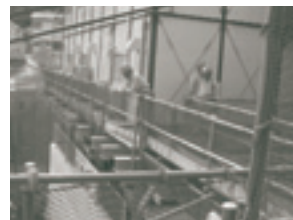
作業構台端部への通路設置
