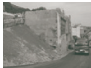
解体構造物の土留利用
