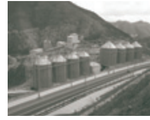
防音ハウスで囲われたコンクリート材料製造設備
