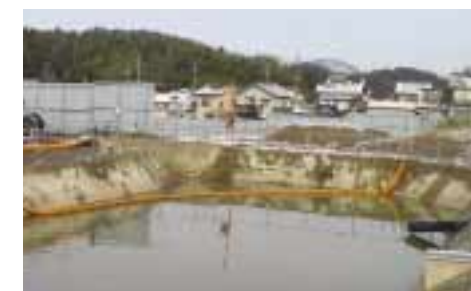
オイルフェンス設置状況
