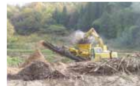
伐採材の破砕作業状況
