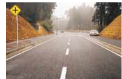
排水性ポリマーセメントコンクリート舗装 (千葉県香取郡の主要地方道)
