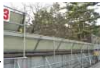
樹木に対する配慮 仮囲いにつかる枝がある場合は、枝を避けて設置
