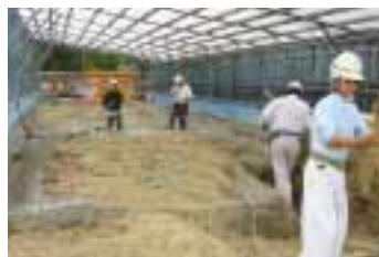
掘削土の再利用 掘削土から出てきた聚楽土をふるいにかけて、水でこねて熟成、左官材に利用
