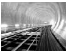
トンネル内部
