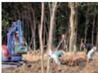
宅地造成工事(愛知県)で、元の雑木林を調査して保全すべき樹木を選定し、造成地内の計画緑地に移植
