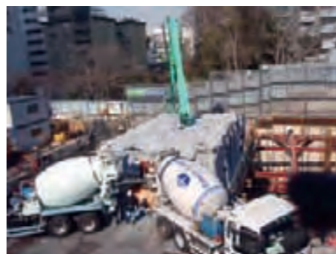
住宅地での工事には、コンクリートポンプ車全体を防音シートで囲み騒音対策を実施
