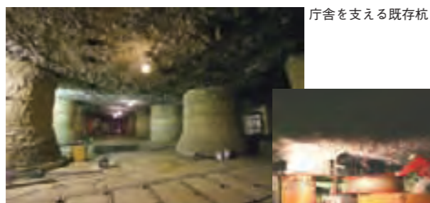
ジャッキで支える既存杭に 免震装置を設置
