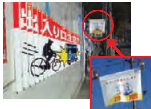
通行者と工事車両の接触を防ぐために、斜めから見える看板や音声+ライト+遮断機で注意を促す標識を製作・設置
