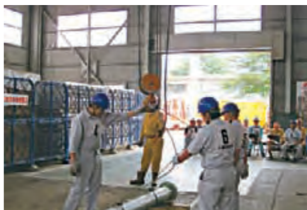
玉掛け作業時の災害防止を目的とした「玉掛け技能向上教育」
