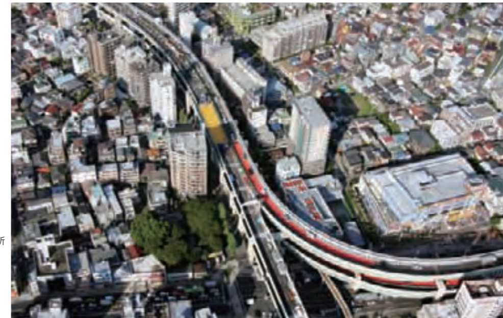
上空から見た現場付近。 路面の黄色い部分が補修箇所
