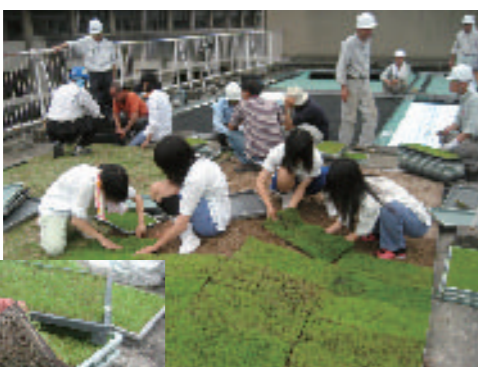
実施された屋上緑化試験
