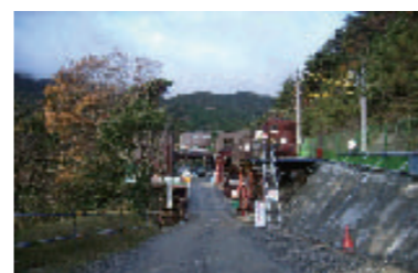
トンネル工事仮設備を周辺景観に溶け込ませる塗装
