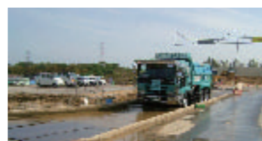
ダンプトラックのタイヤについた泥を建設現場から出る時に洗浄
