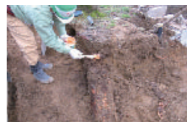
建設現場内に残す樹木の根の手入れ
