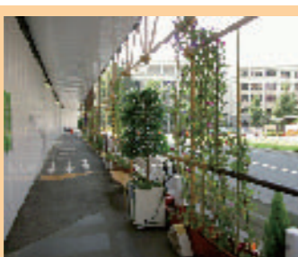
緑化活動（日赤広尾医療センター工事事務所） 現場周辺の緑化活動に現場全員で取り組んでいます。
