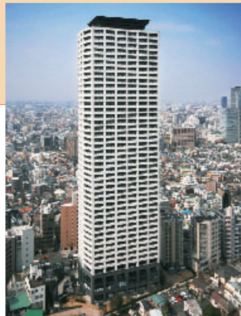
コンシェルリア西新宿TOWER'S WEST LRV工法を採用し、従来はワンフロアあたり6~8日要した躯体工事を2.5日で施工し、全体工期では10~20%程度の工期短縮が可能となりました。
