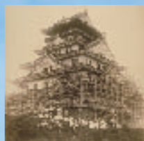
大阪城天守閣の改修
