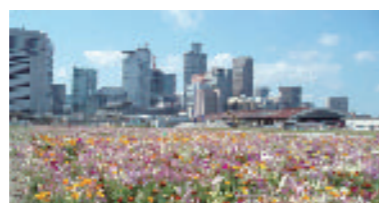
建設現場内の土埃が周辺に飛散するのを防止するため緑化
