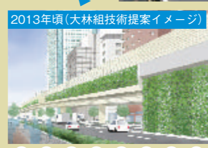
首都高速中央環状線 所在地：東京都新宿区 発注者：首都高速道路(株) 東京建設局
