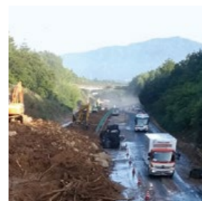
流入物を移動して1車線を確保(山陽自動車道復旧工事)
