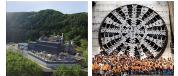
2018 大月バイオマス発電所
