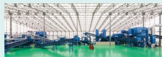
受入・分別施設内全景
