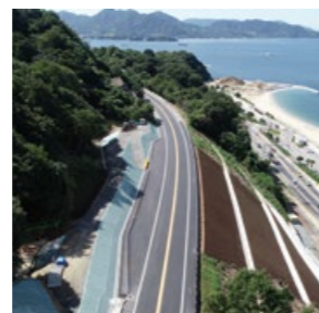
2018年9月27日には、広島呉道路の本線の通行が再開
