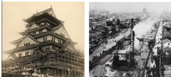
1931 建設中の大阪城天守閣
