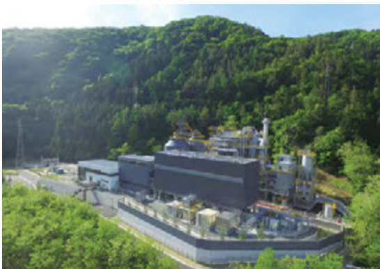
大月バイオマス発電所
