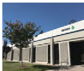
コラボレーションオフィス
