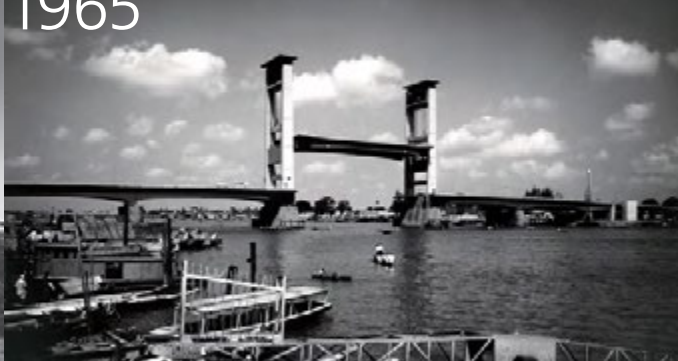
海外進出の先駆けとなったインドネシアのムシ大橋
