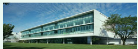
技術研究所 本館テクノステーション お客様や学生など年間約4,000~5,000人もの見学者が訪れる
