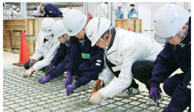
鉄筋の組み方を学ぶ高校生
