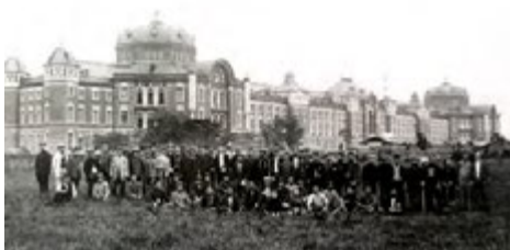
当時日本最大の鉄骨を使用した東京中央停車場（現：東京駅）を皮切りに、港湾や鉄道などのインフラ建設事業など近代化に貢献
