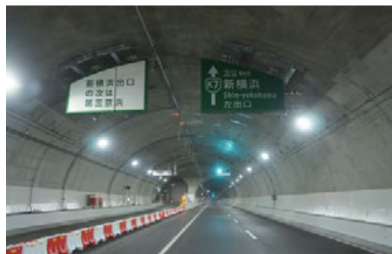
横浜北線トンネルの本線(右)と出口(左)の分岐部
