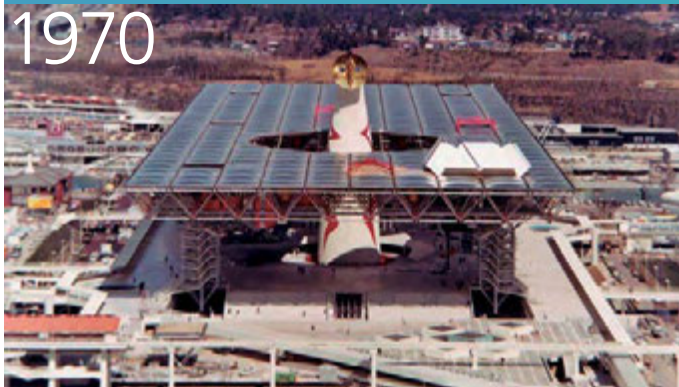
日本万国博覧会（テーマ館）の大屋根にはこれまでになかったスケールのリフトアップ工法を採用
