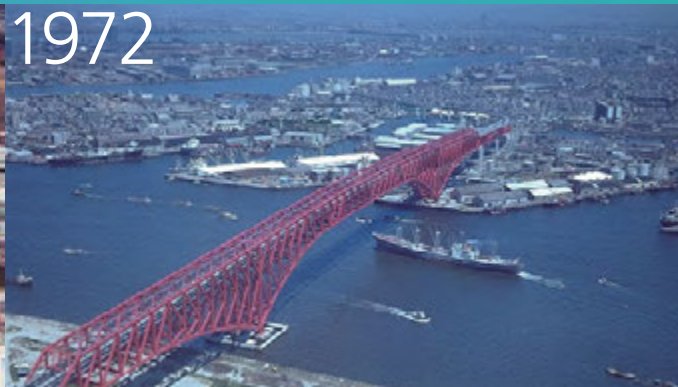
竣工当時わが国のトラス橋としては支間最長の道路橋であった阪神高速道路5号湾岸線 港大橋
