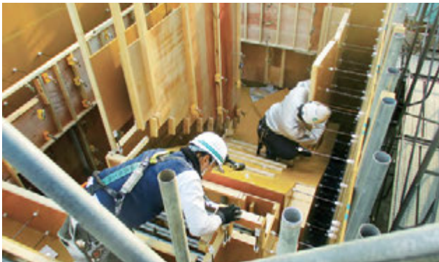
型枠の組み立てを、実際の作業を通じて習得
