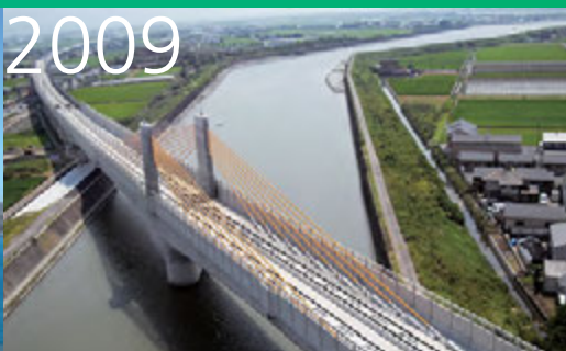
九州新幹線大野川橋りょう
