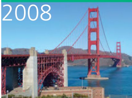
ゴールデンゲートブリッジ耐震補強
