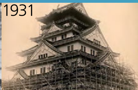
昭和天皇即位の礼に際して再建された、大阪城天守閣
