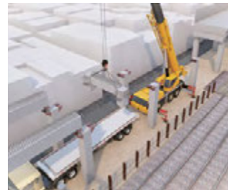
新幹線のラーメン高架橋として初のプレキャスト化事例となる北陸新幹線福井開発高架橋工事(現在施工中)
