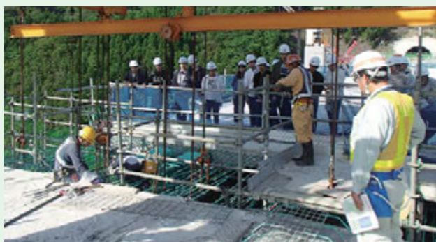
大学などの各種教育プログラムに協力しています。理系の大学生を対象に行った見学会では、高架橋の施工方法について専門的な説明を行いました
