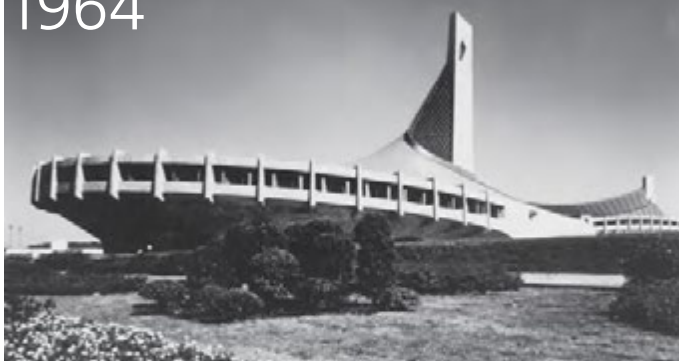
国立代々木競技場第二体育館は東京五輪開催に向けて建設された。ケーブルを用いた吊り天井による曲線屋根は、日本モダニズム建築の代表作
