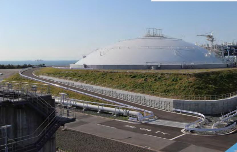
エネルギーの安定供給や原料調達の多様化への対応、また安全・安心なインフラ整備への意識の高まりを受けて、貯蔵容量22万kl(内径74.5m×液深50.7m)を誇る世界最大級の地下式LNGタンクが計画されました。
