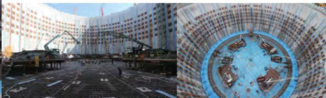
京奈和自動車道和歌山JCTに位置する急峻な地形に大口径深礎工法を用いて高橋脚を構築した後、橋脚の中心からバランスを取りつつ左右対称に道路桁を伸ばしていく「片持架設工法」を用いて橋梁を架設しました。同工法によるPC連続ラーメン箱桁橋では国内屈指の支間長(最長154m)を誇ります。
