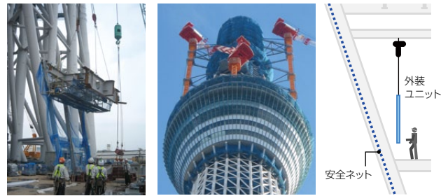
(左) 安全ネットはあらかじめ地上で部材に取り付けておきます (中・右) 高所に部材を設置した際にはネットで覆われた安全な作業空間ができます。作業時の落下物対策となるとともに、未知の高さで作業を行う作業員の安全も確保します
