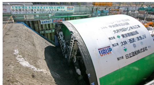
URUP工法で地上から発進するシールドマシン。URUP工法は、立坑を構築せずにトンネル掘削できることが特徴
