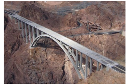
フーバードム バイパスプロジェクト コロラドリバー橋
