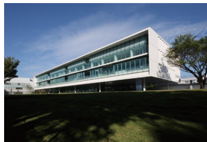
大林組技術研究所本館
