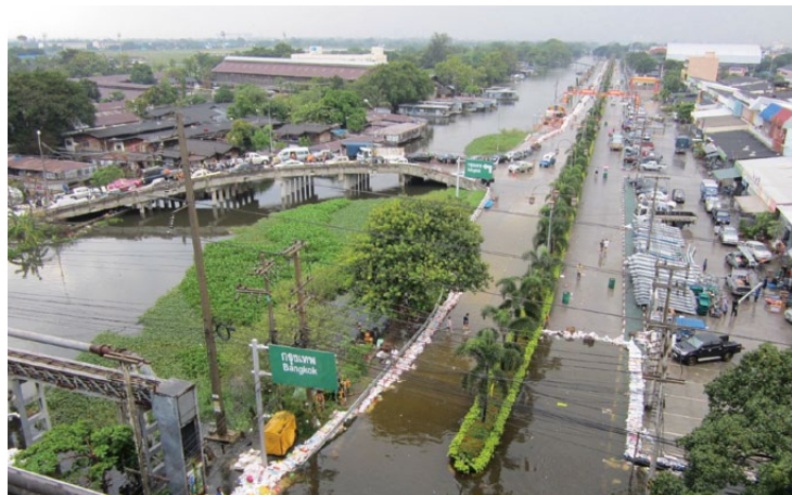
冠水したバンコック市街地の様子
