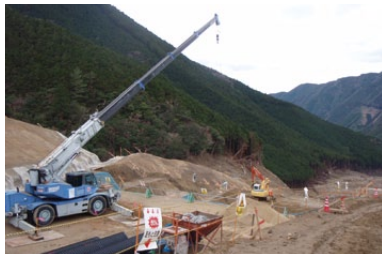
排水路設置工事の様相
