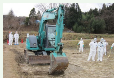
重機を使って表土を剥ぎ取る除染作業の様子
