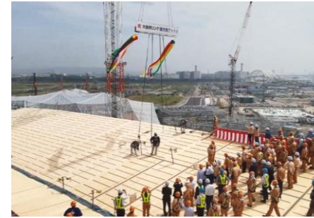
大阪・関西万博会場 大屋根リング 建方完了式典
