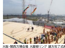
大阪・関西万博会場 大屋根リング 建方完了式典
