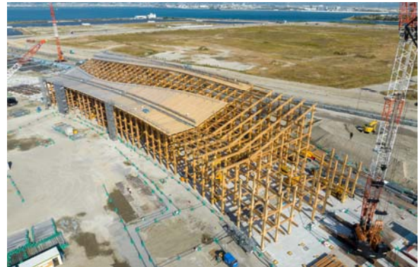
PW北東工区大屋根(リング)施工状況
