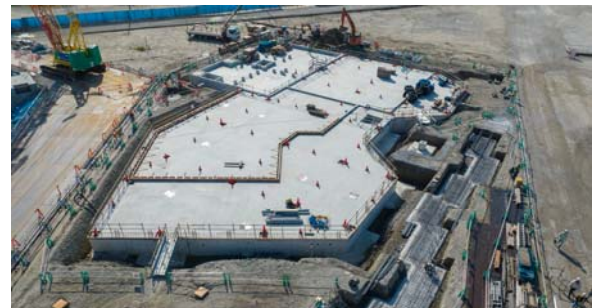
パナソニックグループパビリオン施工状況
