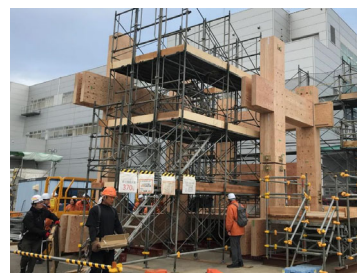
大林組研修施設【建て方試験】
