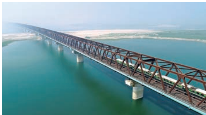
ジャムナ 鉄道橋建設工事 東工区 パッケージ WD1 (バングラデシュ)
