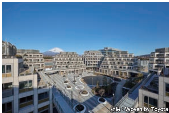
Toyota Woven City Phase1 建築本体工事（静岡県）
