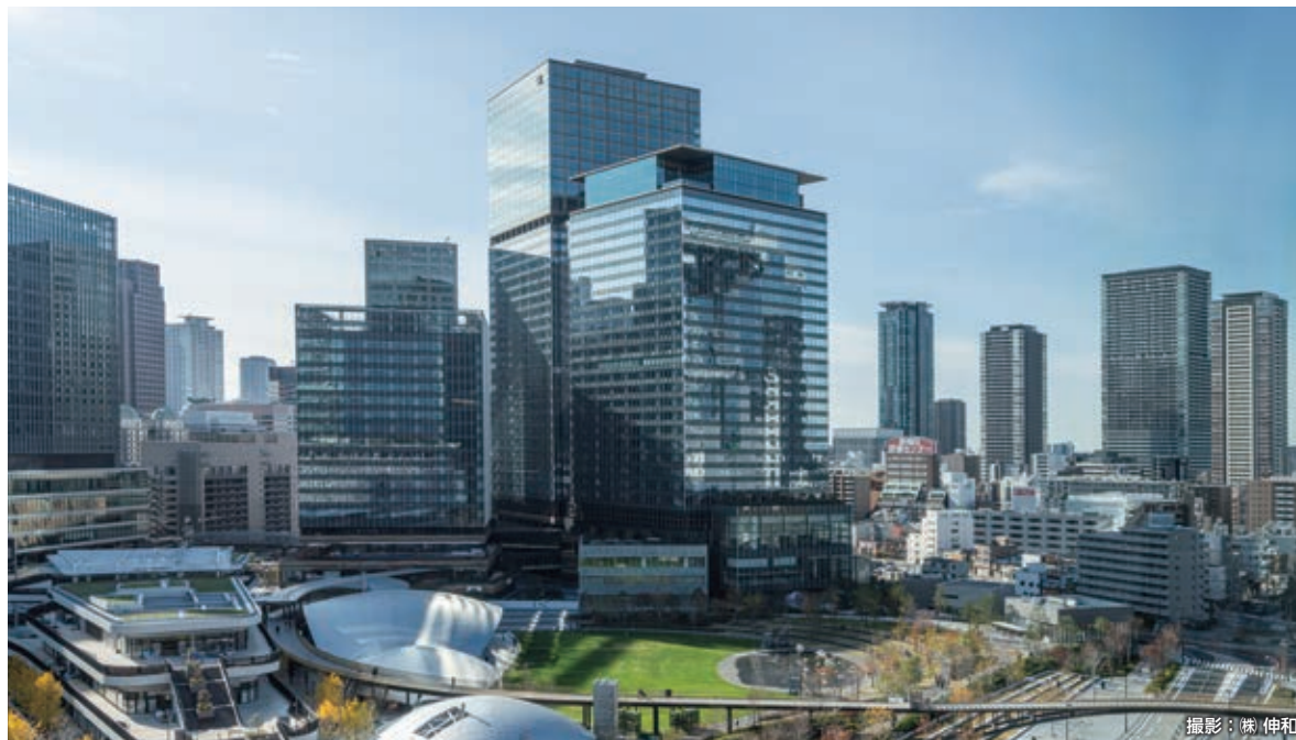
グラングリーン大阪 新築工事（大阪府）
