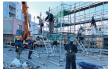
大林組林友会教育訓練校での仮設足場組立訓練
