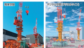
ORCISM ® （※2）によるデジタルツインを活用したクレーンの遠隔・自動運転
