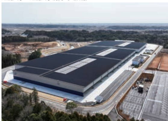
（仮称）ヒロセ関東新工場プロジェクト（茨城県）
