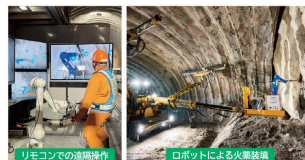
リアルハプティクス ® （※1）を応用し、切羽直下での火薬装填作業を無人化
