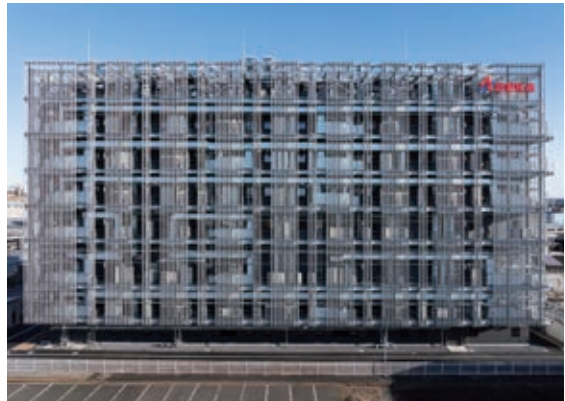
（仮称）株式会社A D E K A久喜新研究棟建設計画（埼玉県）
