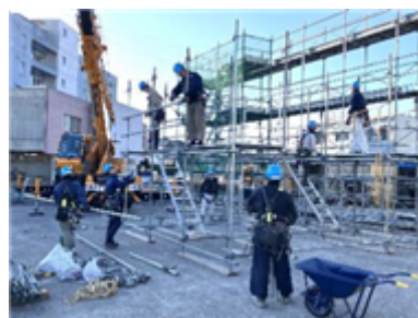
大林組林友会教育訓練校での仮設足場組立訓練
