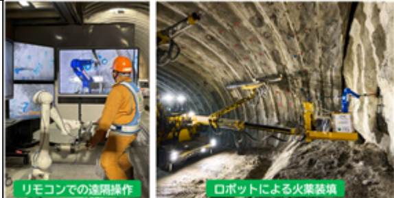
リアルハプティクス®(1)を応用し、切羽直下での火薬装填作業を無人化
