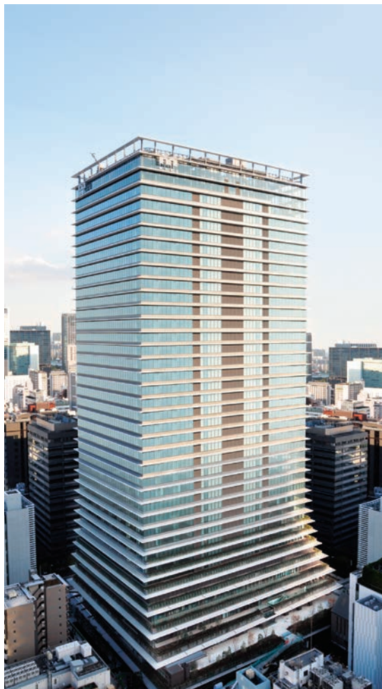
虎ノ門ヒルズ ビジネスタワー新築工事（東京都）
