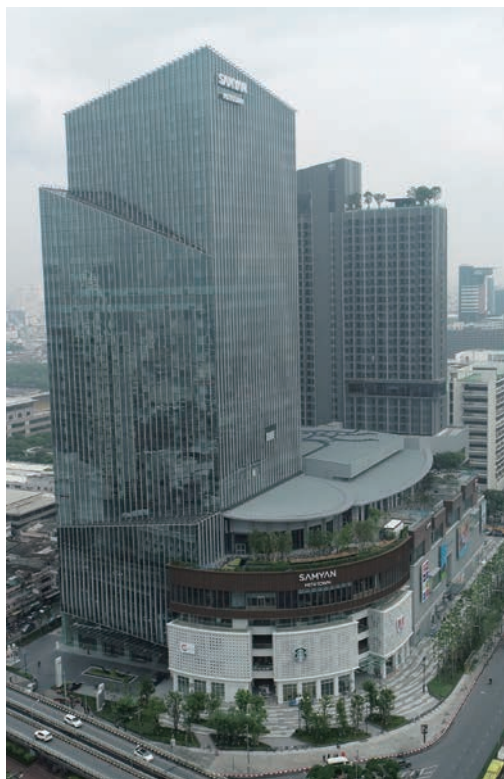
サムヤン・ミッドタウン新築工事 (タイ)
