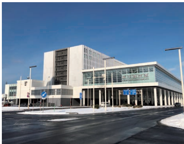
新千歳空港国際線旅客ターミナルビル施設再整備工事（北海道）
