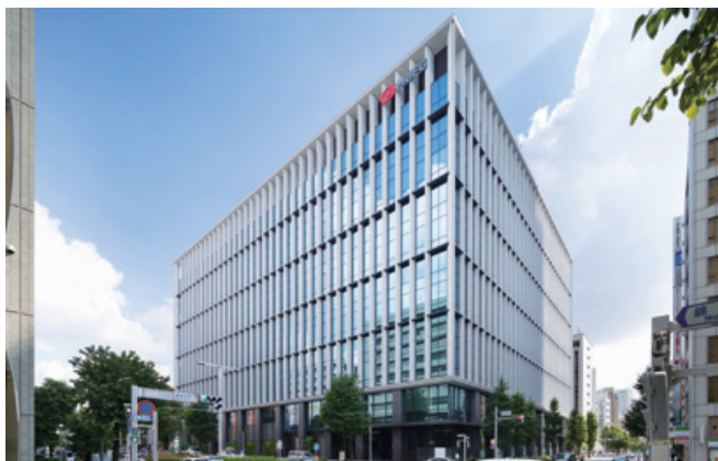
(仮称)N3計画 新築工事(愛知県)
