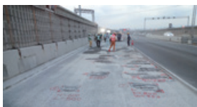
スティフクリート施工前
