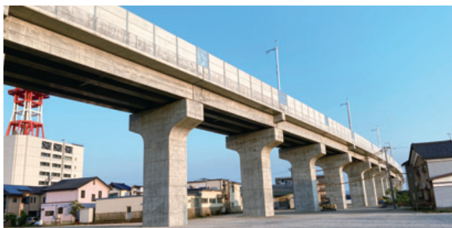
北陸新幹線 福井開発高架橋建設工事(福井県)
