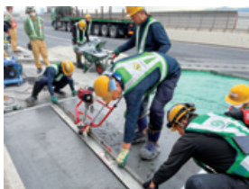
スティフクリート施工中
