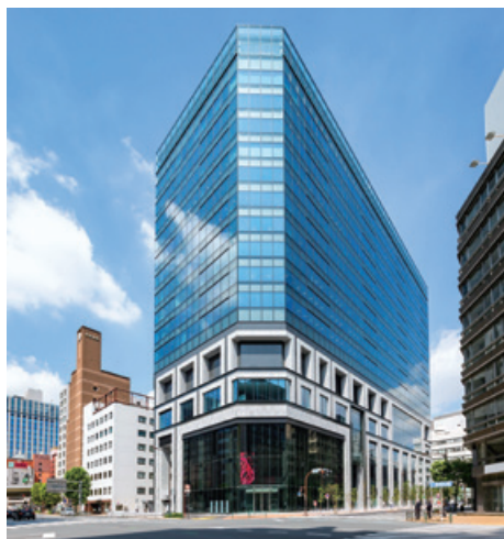
KABUTO ONE新築工事 (東京都)
