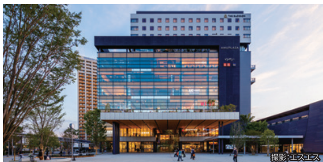
熊本駅ビル(仮称)新築他工事(熊本県)
