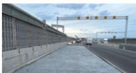
スティフクリート施工後
