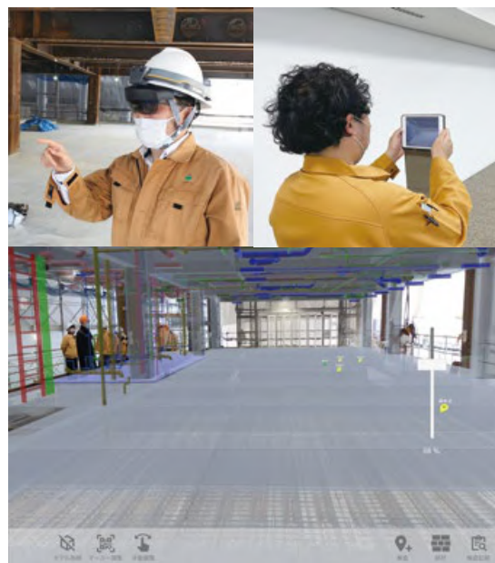
メガネ型・タブレット型端末を用いて仕上げ検査をする様子
