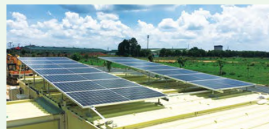
工事事務所の屋根上に太陽光パネルを設置
