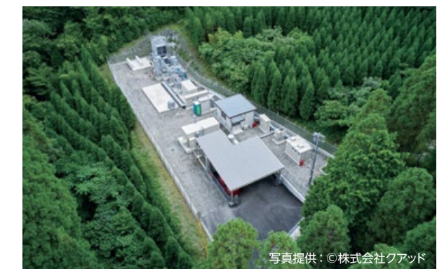
山間部の約1,500m 2 の敷地に地熱発電と水素製造の設備を備える 写真提供：©株式会社クアッド
