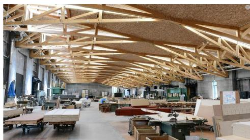
木×コンクリートのハイブリッド構造による大規模工場
