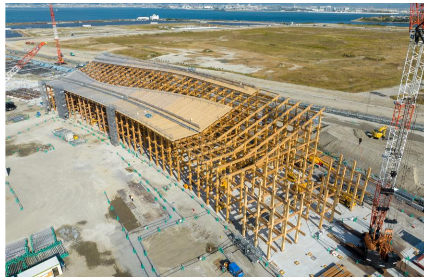
PW北東工区大屋根(リング)施工状況
