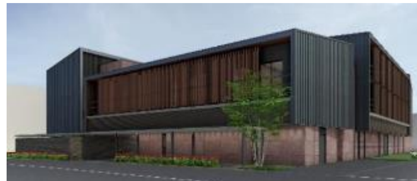
「大林組 仙台梅田寮(上写真)」木造躯体工事におけるプロミエの活用
