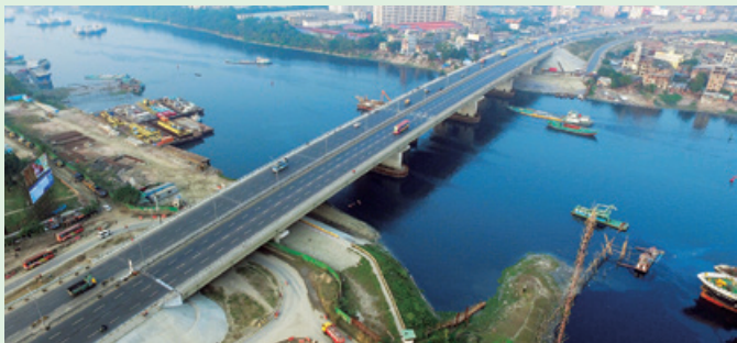
4車線の既存橋（左）に新たに4車線（右）が加わり8車線となったカチプール橋（2020年1月竣工）
