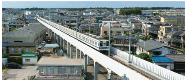
東武野田線高架化工事(清水公園駅～梅郷駅間)のうち 土木関係3工区その1工事(千葉県)
