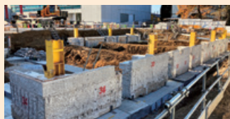
設置したリユース基礎部
