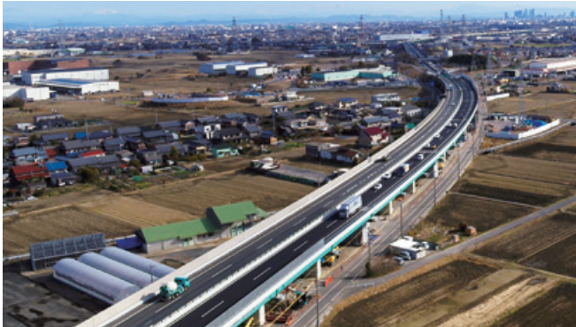
東名阪自動車道 弥富高架橋(下り線)床版取替工事(愛知県)
