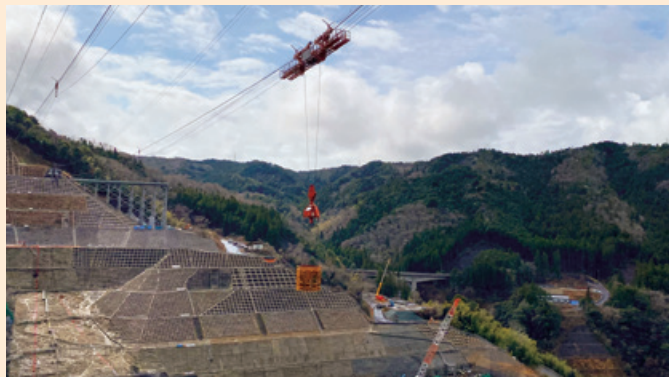
ケーブルクレーンの自動・自律運転システムでコンクリートを運搬
