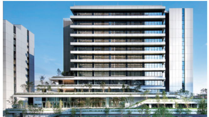
(仮称)NECイノベーション新棟建設工事(神奈川県) 撮影：雁光舎
