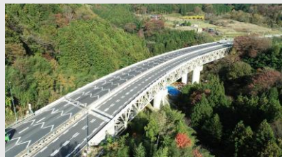
中央自動車道 柳樽川橋他9橋 橋梁補修
