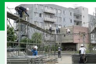
仮設足場の組み立て訓練の様子
