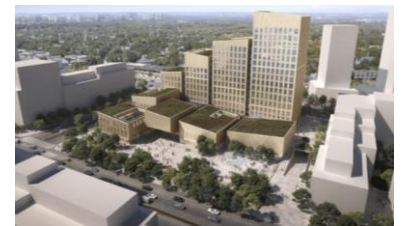
Etobicoke Civic Centre Precinct (公共施設、トロント)
