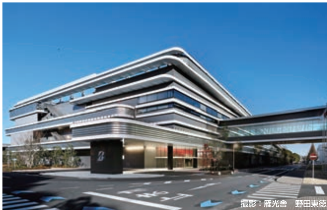
Bridgestone Innovation Park新築工事（東京都）
