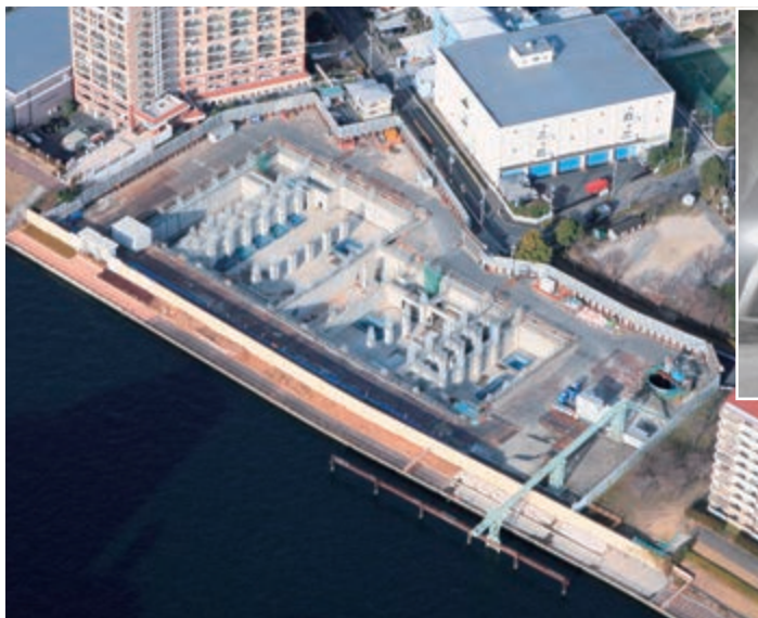
千住関屋ポンプ所建設工事（東京都）
