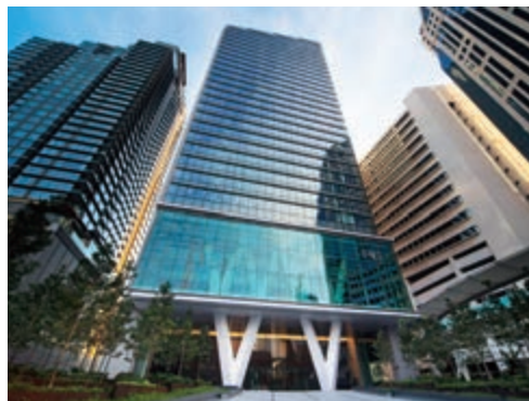
地下5階、地上29階建ての超高層オフィスビル
