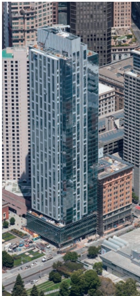
706ミッションストリート新築工事（米国）
