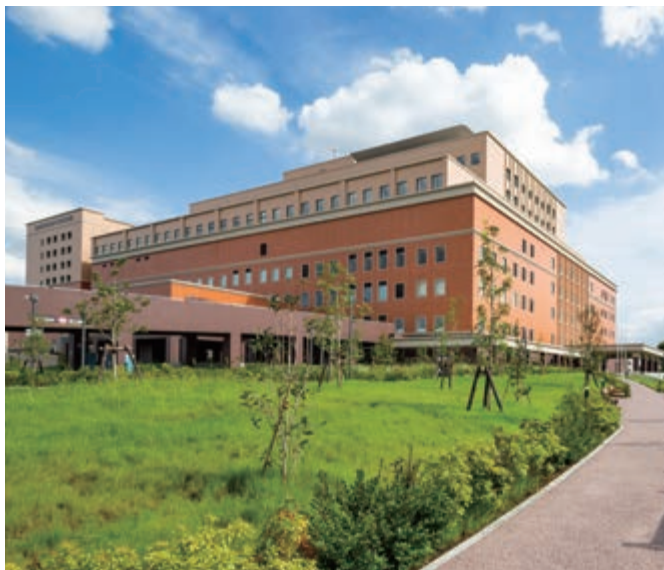
東京女子医科大学附属独立医療センター建設工事（東京都）
