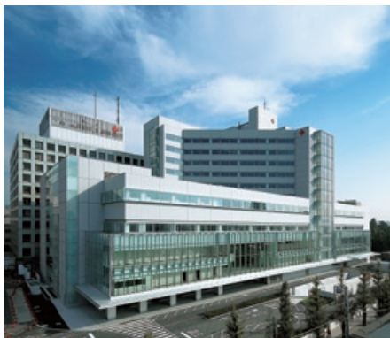
日本赤十字社医療センター建物建設工事(東京都)
