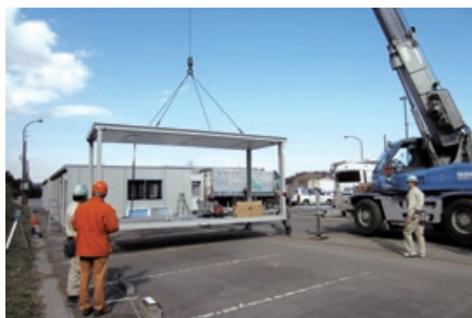
宮城県南三陸町の避難所(スポーツ交流村)の駐車場に、プレハブ平屋の診療所6棟を設置
