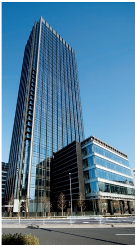
後楽二丁目西地区第一種市街地再開発事業施設建築物 新築工事(東京都)
