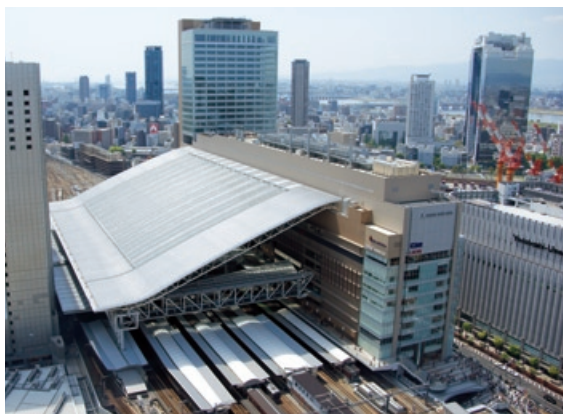
駅のホームを覆う巨大なドーム屋根。その一端を支えているのがノースゲートビルディング
