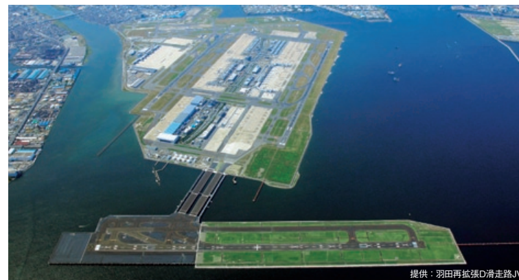
東京国際空港D滑走路建設外工事(東京都)
