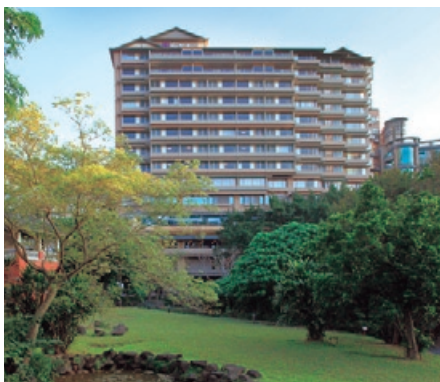
日勝生加賀屋温泉飯店建設工事(台湾)
