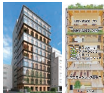
当社の次世代型研修施設として高層純木造耐火建築物を建設中
