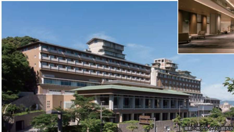
ウェスティン都ホテル京都耐震改修およびリニューアル工事（京都府）
