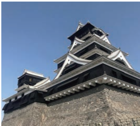
熊本城天守閣復旧整備工事（熊本県）
