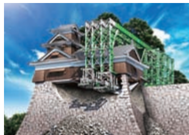
飯田丸五階櫓石垣復旧工事
