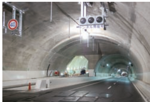
馬場分合流拡幅部の完成状況
