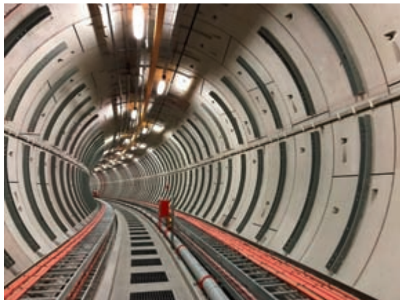
シンガポールケーブルトンネル東西線EW1工区建設工事（シンガポール）
