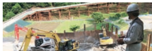
遠隔操作で土砂を集積する様子
