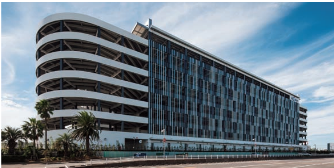
三井不動産ロジスティクスパーク船橋新築工事（千葉県）
