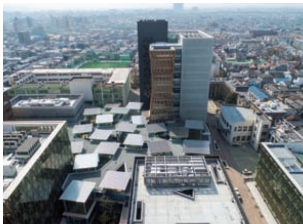
近畿大学東大阪キャンパス整備 I 期工事 (大阪府)
