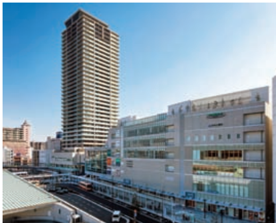
パピオスあかし新築工事（兵庫県）
