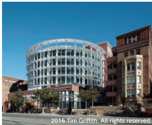
サンフランシスコ総合病院新築工事 (米国)
