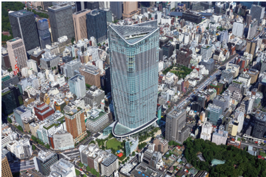
虎ノ門ヒルズ、環状第二号線 築地虎ノ門トンネル建設工事 (東京都)
