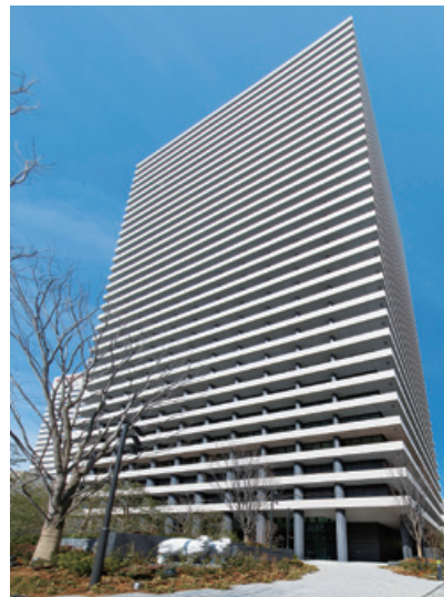
新ダイビル新築工事 (大阪府)
